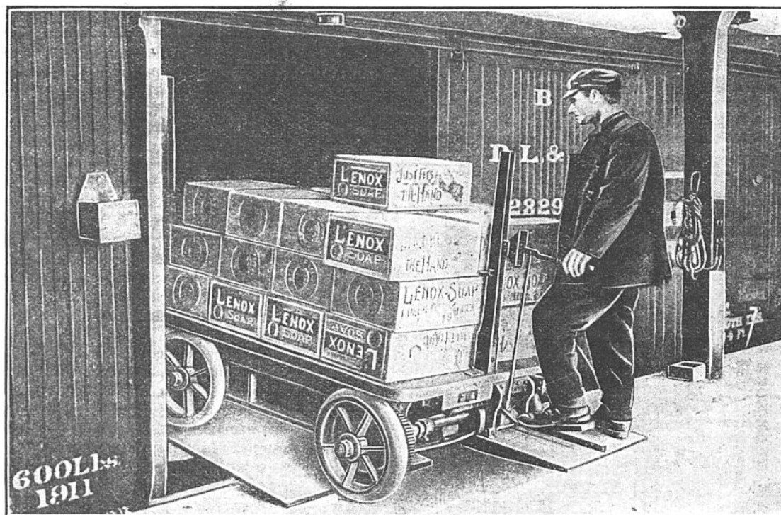
CHARIOT ÉLECTRIQUE PÉNÉTRANT DANS UN WAGON AVEC SON CHARGEMENT On voit avec quelle rapidité on arrive ainsi à remplir un wagon de caisses cont. nées des marchandises.
