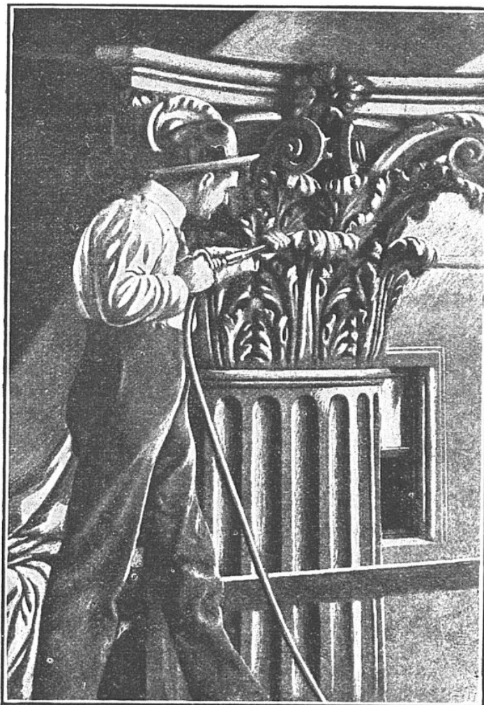
SCULPTURE D'UN CHAPITEAU DE COLONNE A L'AIDE DU MARTEAU PNEUMATIQUE
