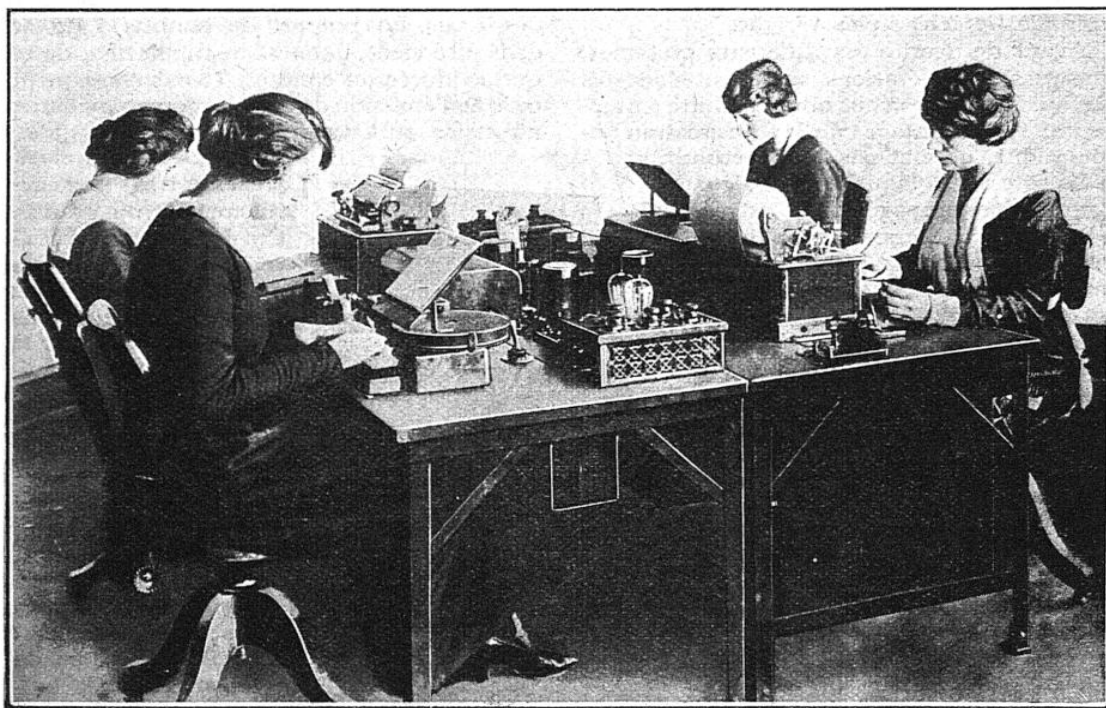
TÊTES DE DEUX CIRCUITS TÉLÉGRAPHIQUES EXPLOITÉS EN « DUPLEX »
