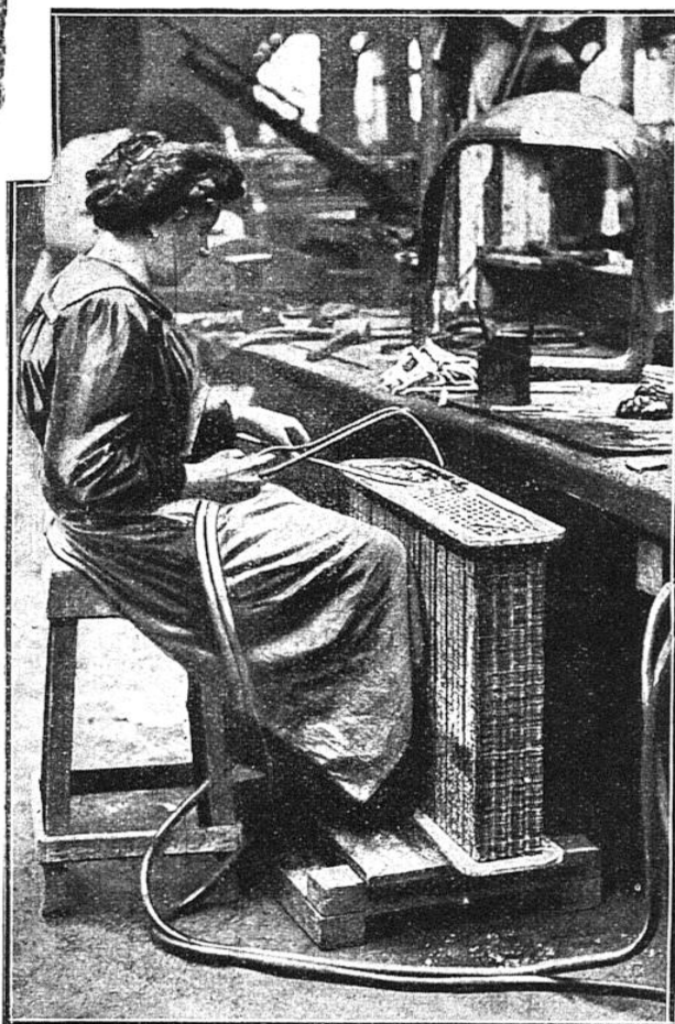
LA CONSTRUCTION D'UN BLOC DE RADIATEUR
