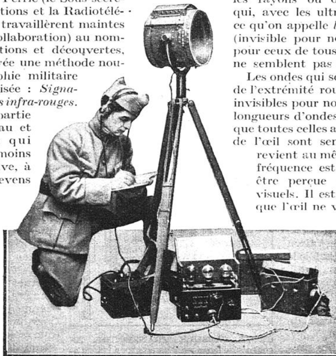
LA RÉCEPTION AU SON D'UN MESSAGE INFRA-ROUGE Les signaux, codifiés au Morse, sont reçus par l'opérateur absolument comme s'il s'agissait de messages de T. S. F.
