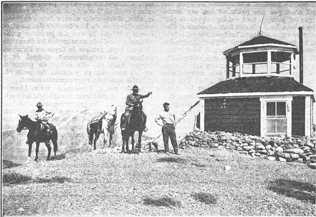
POSTE D'OBSERVATION ÉRIGÉ AU SOMMET D'UN PIC ÉLEVÉ, DANS UNE RÉGION BOISÉE Le guetteur vit, pendant toute la saison propice aux incendies, dans la petite habitation que surmonte l'observatoire; il est relié téléphoniquement aux postes de secours et aux patrouilleurs.
