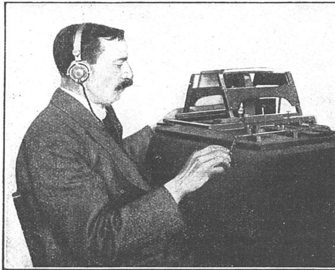
AVEUGLE LISANT... AVEC SES OREILLES, AU MOYEN DE L'OPTOPHONE DU D r FOURNIER D'ALBE
