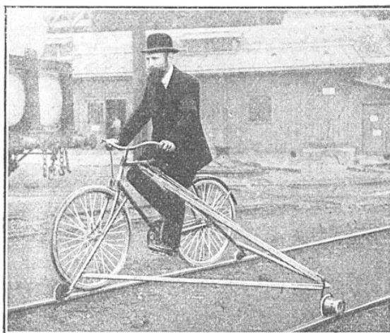
M. MARTIN, SUR LA BICYCLETTE QU'IL A ADAPTÉE AUX DÉPLACEMENTS SUR RAILS
