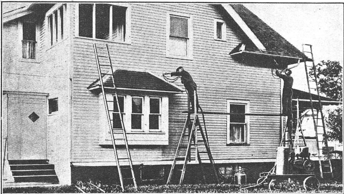
VILLA PEINTE EXTÉRIEUREMENT A L'AIDE DU PISTOLET A AIR COMPRIMÉ L'air nécessaire à la projection est comprimé sur place au moyen d'un groupe compresseur mobile.
