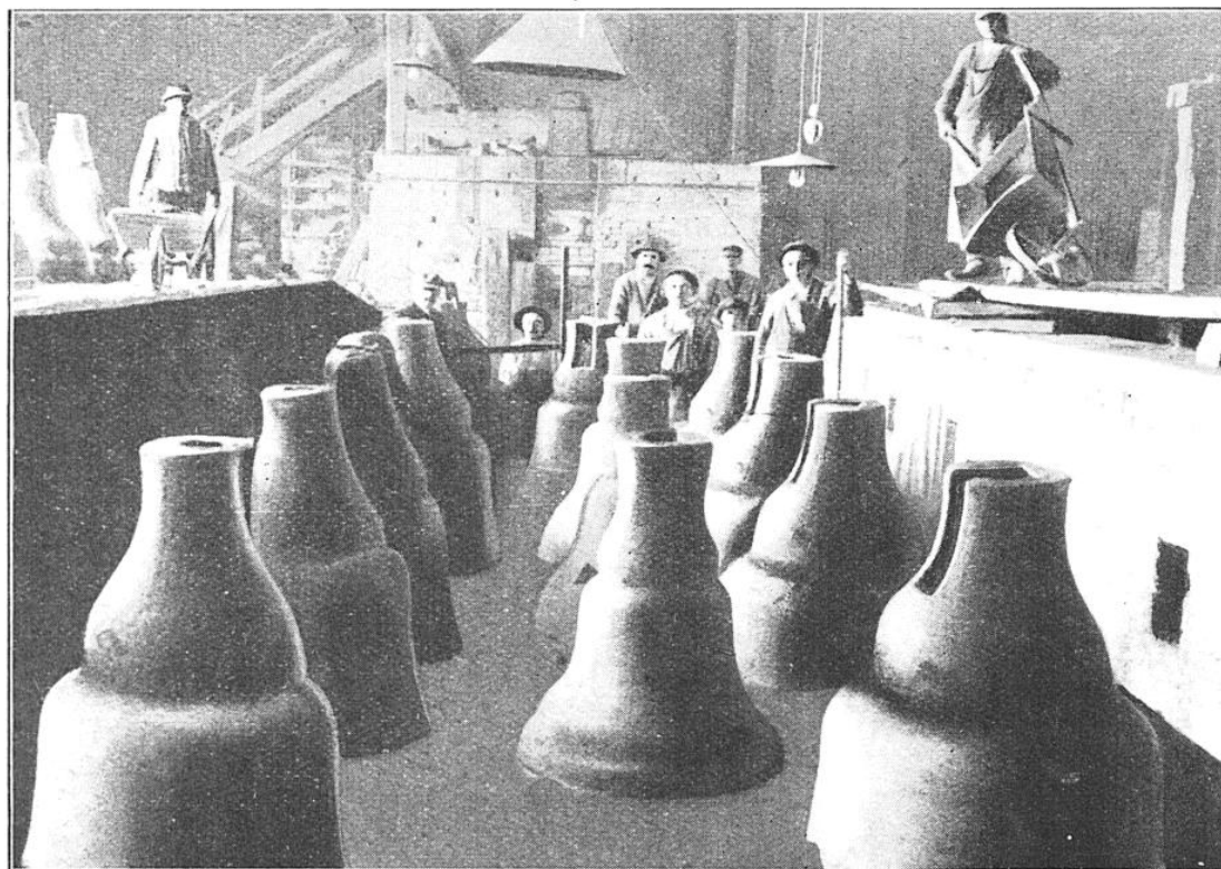
OPÉRATION DITE DE L' « ENTERRAGE », EN VUE D'UNE COULÉE PROCHAINE
