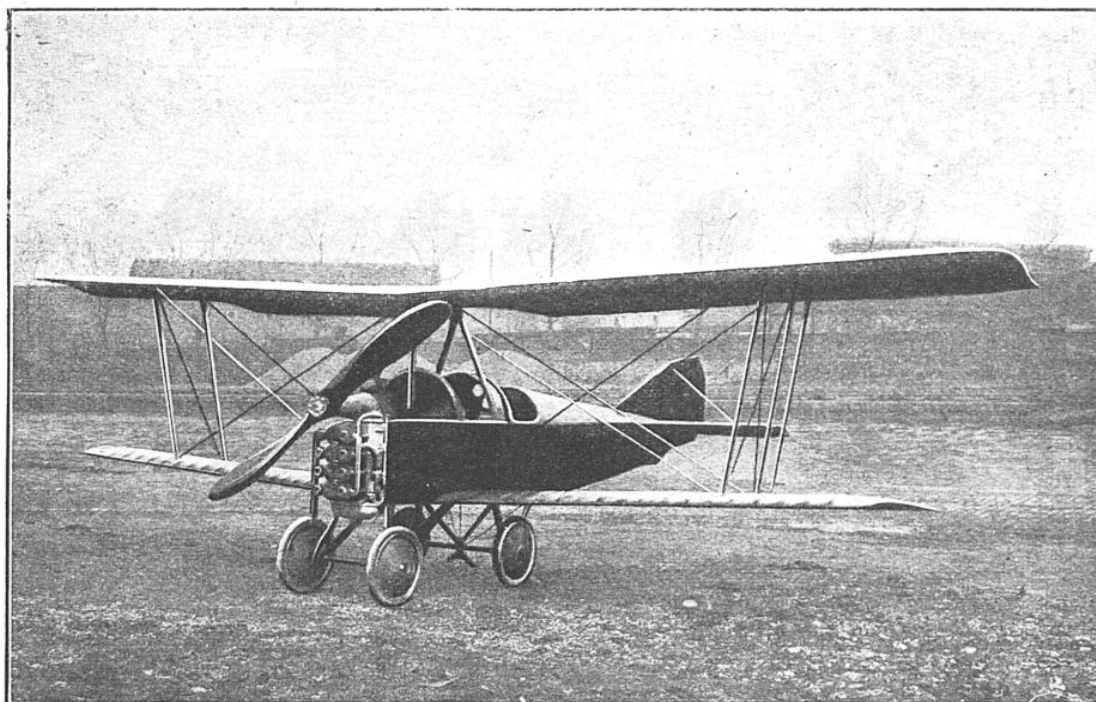
UN AUTRE AVION A FAIBLE PUISSANCE : LE PETIT BIPLAN POTEZ-COROLLER Avec son moteur de 50 chevaux, emportant 160 kilos de charge, cet appareil peut voler 3 heures.
