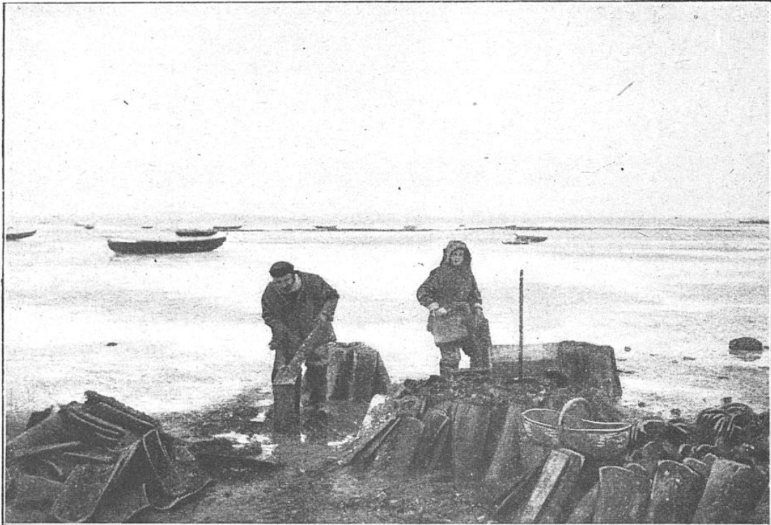
LE « DÉTROQUAGE » DES TUILES SE FAIT À TERRE
