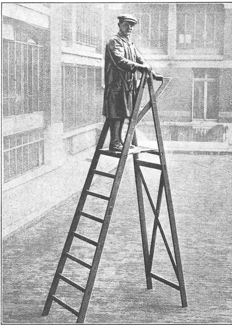
1. L'OUVRIER EST JUCHÉ SUR UNE PLATE-FORME HORIZONTALE
