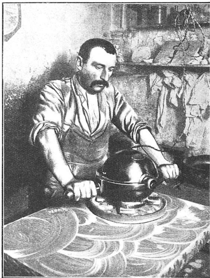
BOURRIQUET ÉLECTRIQUE UTILISÉ POUR LE GRAINAGE DES PIERRES
