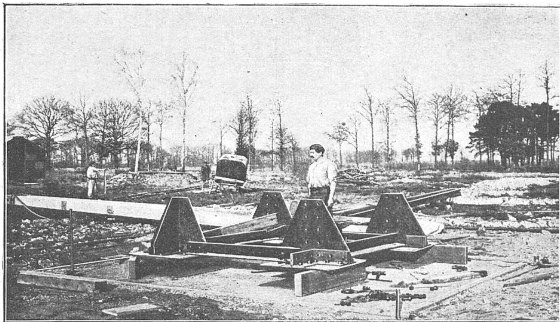
BASE D'UN PYLONE EN CONSTRUCTION, REPOSANT SUR UN MASSIF DE BÉTON DE 50 M 3
