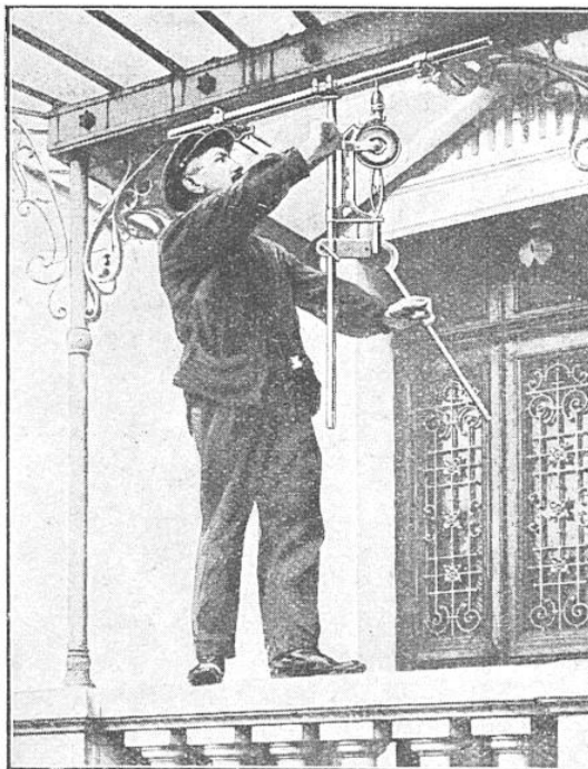
L'OUVRIER PERCE UN TROU DANS UNE PIÈCE MÉTALLIQUE PLACÉE AU-DESSUS DE SA TÊTE L'axe de l'appareil est maintenu fixe grâce à l'emploi de la barre horizontale sur laquelle on assujettit le tube sur lequel est monté la perceuse.
