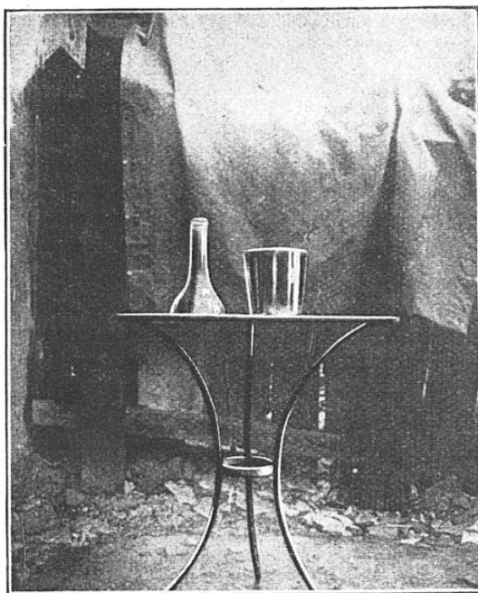
FIG. 7. — PAR LE PROCÉDÉ A L'HUILE, LA BOUTEILLE SE SECTIONNE ÉGALEMENT TRÈS BIEN
