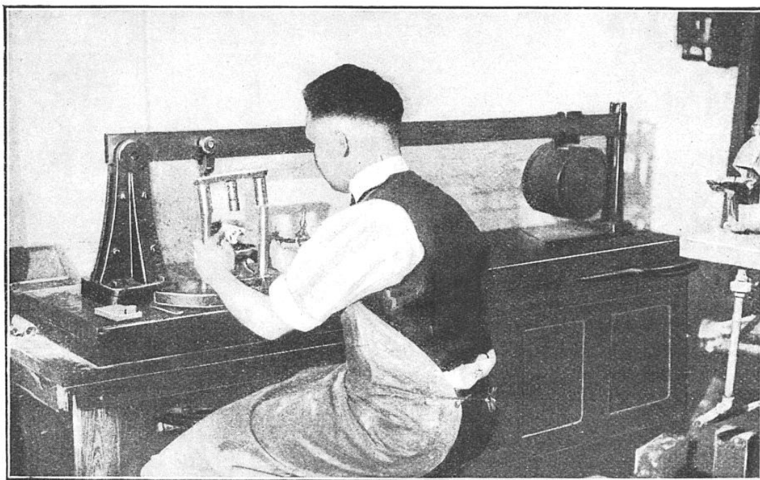
MOULAGE DES BRIQUETTES DE ROCHE BROYÉE DESTINÉES AUX ESSAIS
