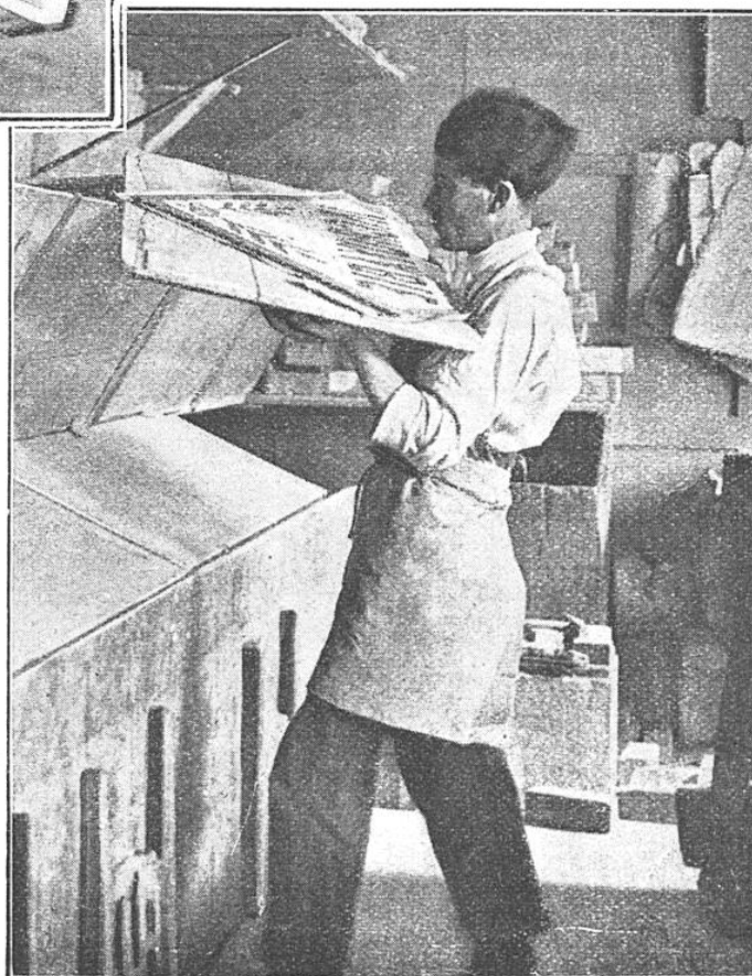
LES CUBES, ASSEMBLÉS ET COLLÉS SUR UNE FEUILLE DE PAPIER ÉPAIS, SONT MIS A L'ÉTUVE POUR LE SÉCHAGE
