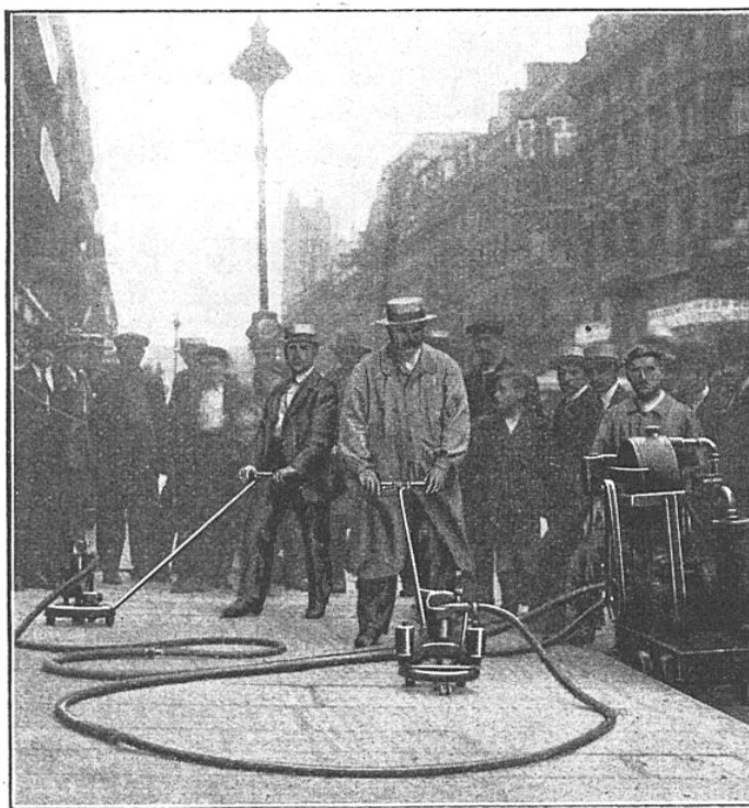
BOUCHARDAGE DES DALLES D'UN TROTTOIR A L'AIDE D'APPAREILS A AIR COMPRIMÉ, ACTIONNÉS PAR UN MOTEUR A PÉTROLE MONTÉ SUR UN PETIT CHARIOT
