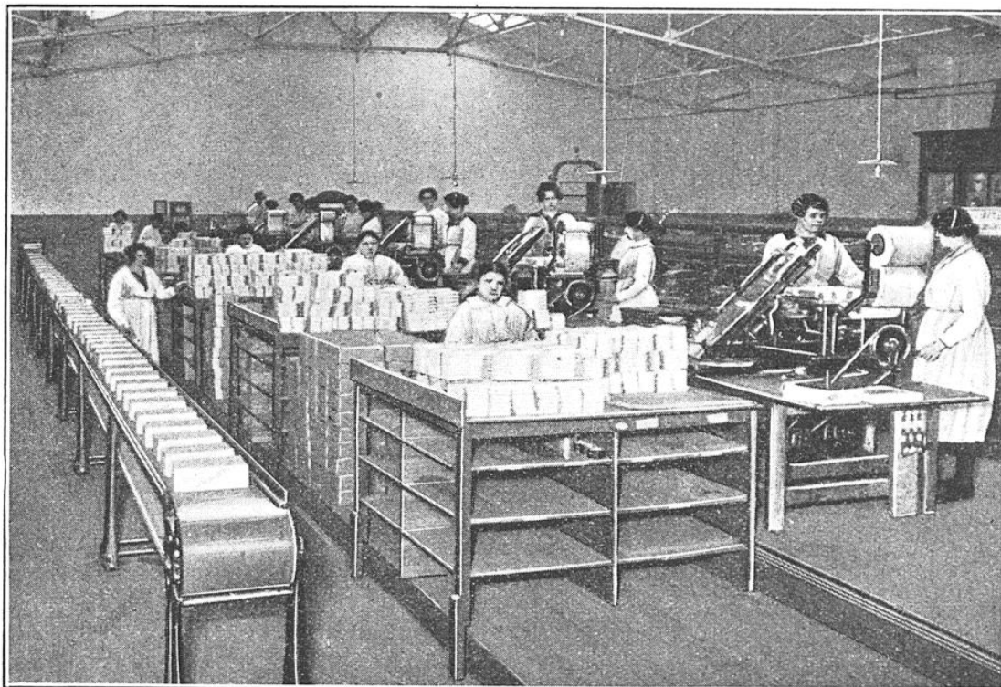
L'ENVELOPPAGE MÉCANIQUE DES TABLETTES ET LEUR MISE EN PAQUETS DE 5 KILOS
