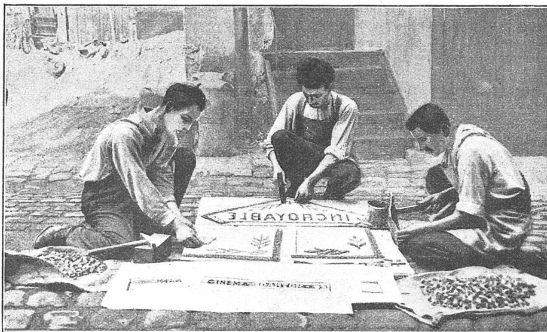
COMMENCEMENT DE L'ASSEMBLAGE DES CUBES POUR UN PAVEMENT
