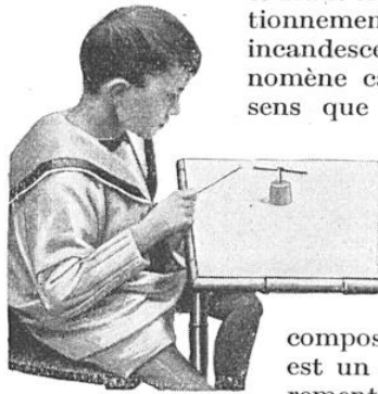
FIG. 1. — LE POLE SUD DE LA BOUSSOLE EST REPOUSSE PAR LE POLE SUD DE L'AIGUILLE
