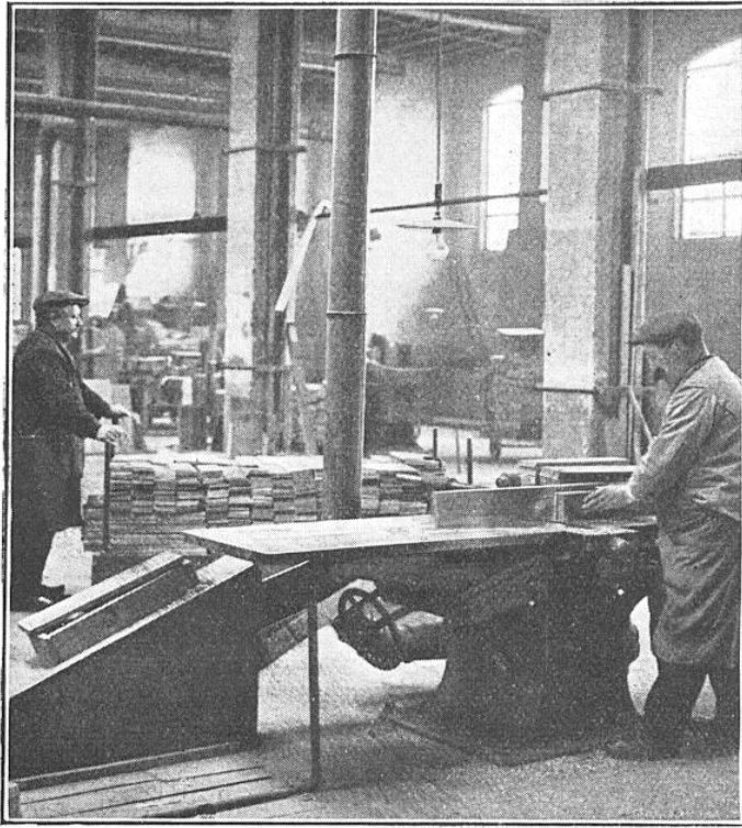
LES DÉGAUCHISSEUSES SERVENT A METTRE LES BOIS A L'ÉQUERRE SUR TOUTES LEURS FACES
