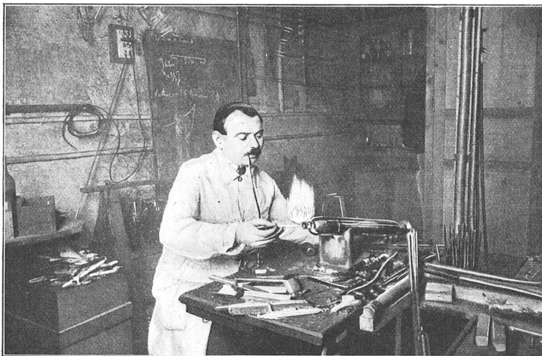
FIG. 4. — FERMETURE AU CHALUMEAU DE L'UNE DES EXTRÉMITÉS D'UN GROS TUBE APRÈS LA MISE EN PLACE DE L'ÉLECTRODE MÉTALLIQUE
