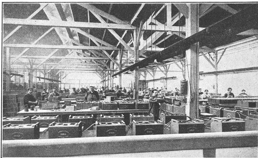
ATELIER DE MONTAGE DES BATTERIES D'ACCUMULATEURS
