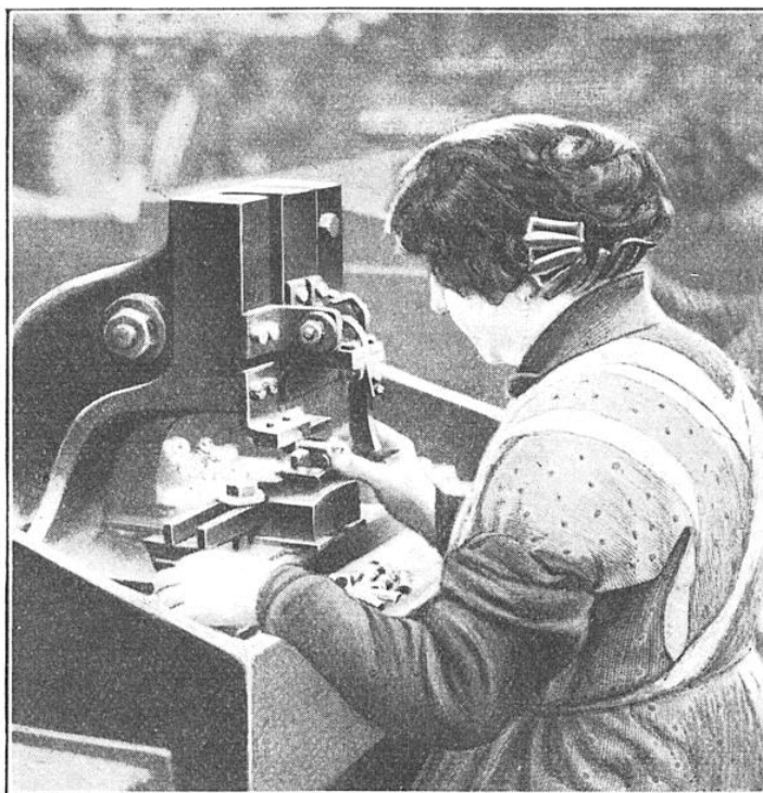
MACHINE A ESTAMPER LES COULISSEUX ET A TERMINER LE BOURRELET
