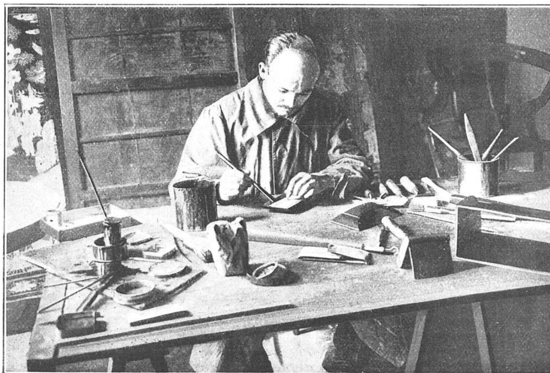
FIG. 8. — APPLICATION DE COULEURS DE LAQUE SUR UNE PIÈCE APPRÊTÉE ET PONCÉE
