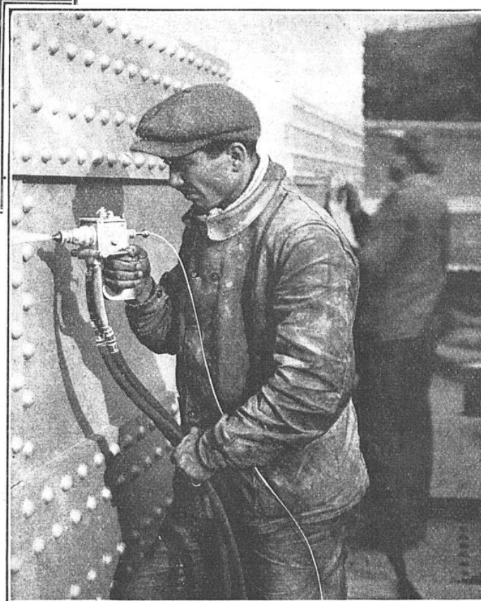
DÉTAIL DE LA MÉTALLISATION DE LA PORTE D'ÉCLUSE DU PORT DE DUNKERQUE (VOIR FIG. PAGE 204)
