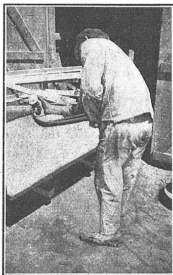
MÉTALLISATION D'UN PYLONE
