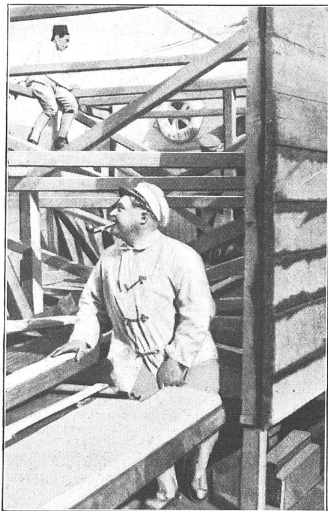
FIG. 8. — CHARPENTAGE D'UN BATARDEAU Cette figure montre la surélévation d'un batardeau qui a déjà permis de décoller une épave, sans l'amener en flottaison.
