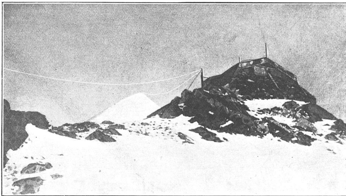
FIG. 2. — REFUGE VALLOT SUR L'ABÊTE DES « BOSSES », A 4.375 MÈTRES D'ALTITUDE Sur cette photographie, on voit nettement les câbles formant l'antenne de captation des courants atmosphériques, câbles recouverts d'une couche épaisse de glace, ce qui les surcharge et les rend extrêmement cassants. Au centre, on aperçoit, au fond, la Grande-Bosse (4.525 mètres), toute blanche de neige, à laquelle venait s'amarrer les câbles-antennes. Le refuge était muni de paratonnerres (mâts métalliques) contre la foudre des orages des hautes couches atmosphériques.
