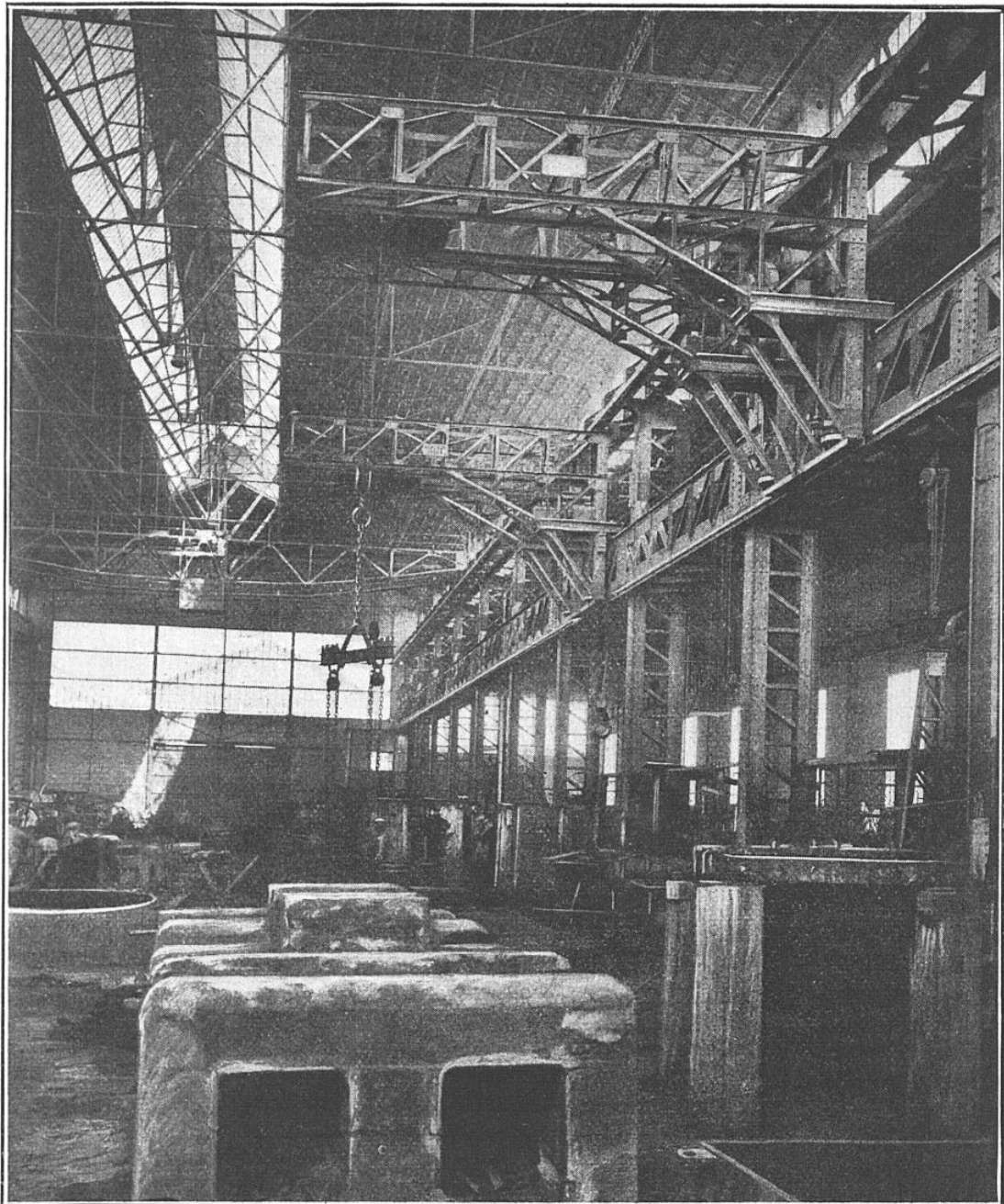
PONT ROULANT INSTALLÉ DANS UN ATELIER TRÈS ÉLEVÉ, POUR LA TREMPE DES PIÈCES D'ACIER DE GRANDE LONGUEUR, DES TUBES DE CANONS, PAR EXEMPLE
