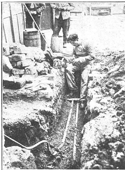
INSTALLATION D'UNE PRISE DE TERRE A RUBAN
