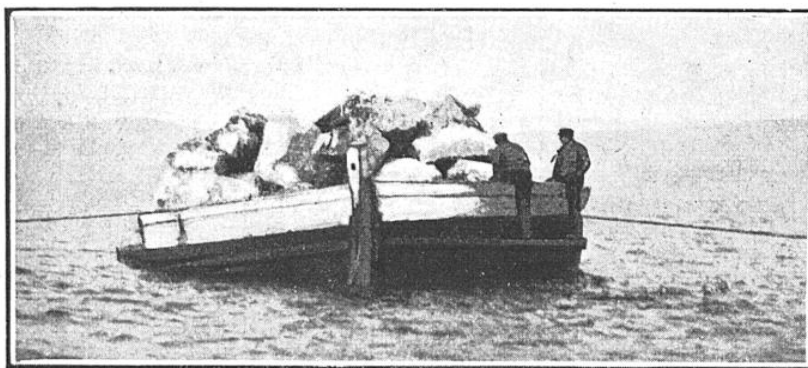
FIG. 5. — IMMERSION DE GROS BLOCS DE ROCHERS POUR LA CONSTRUCTION D'UNE DIGUE
