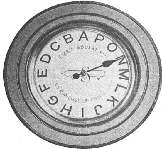
RÉPÉTITEUR D'ÉMISSIONS INSTALLÉ AU POSTE DE COMMANDE DE LA CENTRALE
