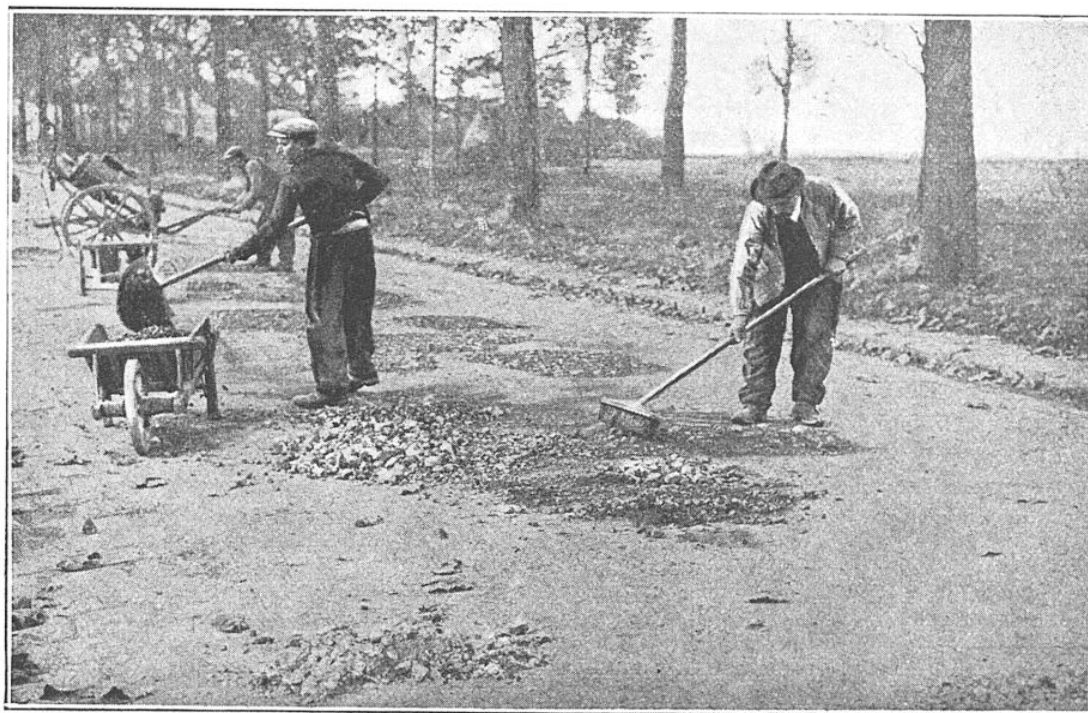
FIG. 3. — CONFECTION DE L' « EMPLOI » (REMBLAYAGE DES FLACHES OU « NIDS DE POULES ») Dans les excavations préparées par la piocheuse, on place des matériaux neufs de dimensions et de nature aussi semblables que possible à ceux de l'empierrement primitif.
