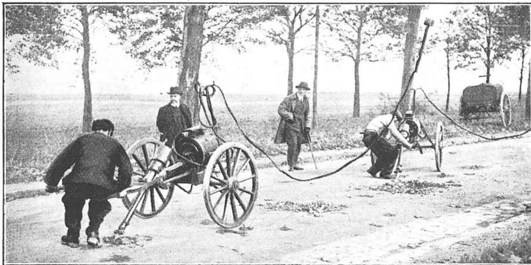
FIG. 1. — RÉFECTION ÉLECTRO-MÉCANIQUE DES ROUTES PAR LES PROCÉDÉS MAURICE COLLET Les « flaches » de la route, délimitées à la craie par le chef cantonnier, sont attaquées par des piocheuses électro-mécaniques fonctionnant à grande vitesse et sans projection ni bris de matériaux.
