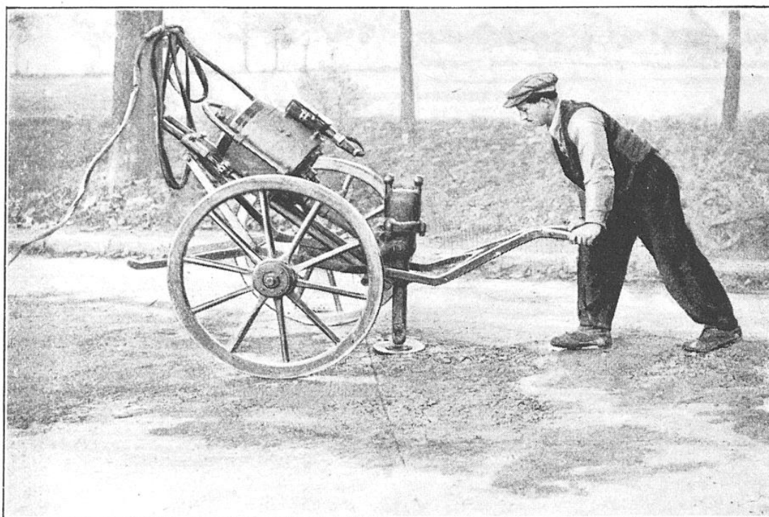
FIG. 4. — PILONNEUSE ÉLECTRO-MÉCANIQUE COLLET AU TRAVAIL
