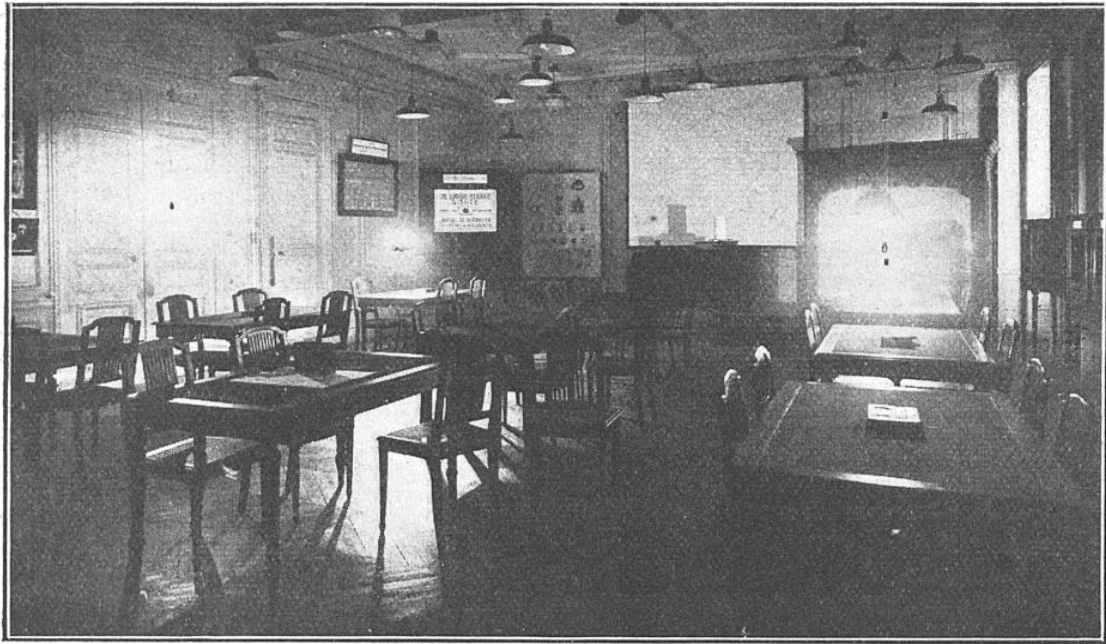
FIG. 5. — L'ÉCLAIRAGE QUE PROCURENT DES LAMPES NUES, SIMPLEMENT SUSPENDUES A BOUT DE FIL ET MUNIES D'ABAT-JOUR PLATS ORDINAIRES
