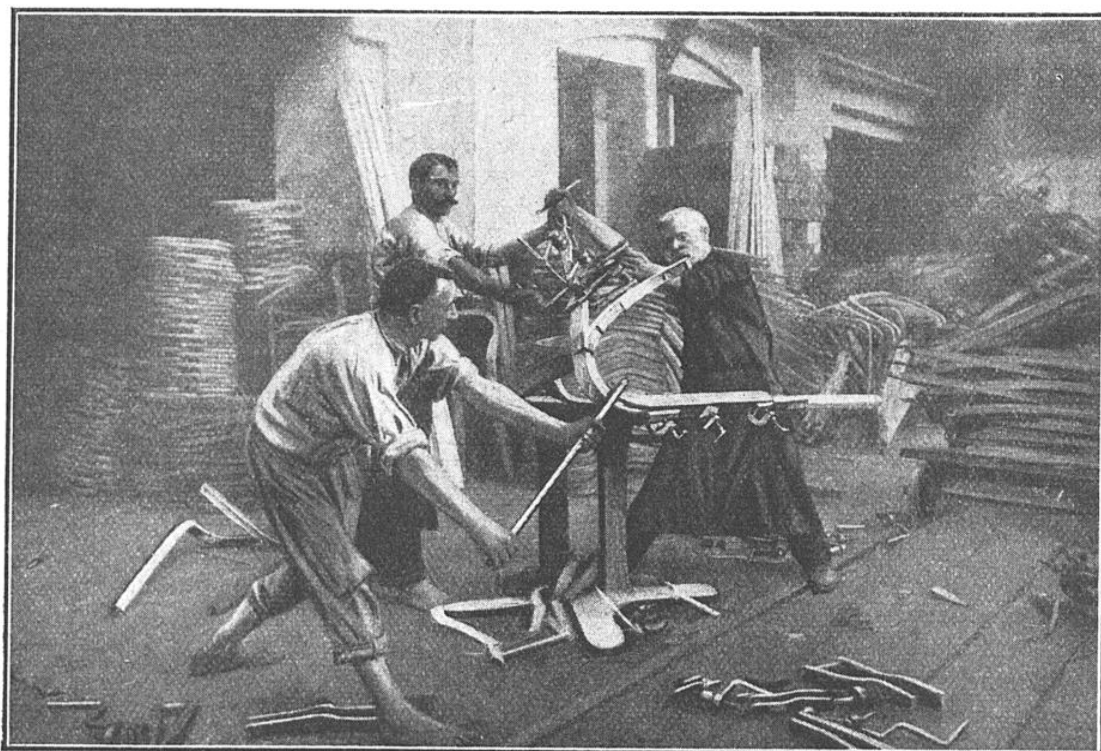
COURBURE DU BOIS, LÉGÈREMENT AMOLLI, APRÈS SA SORTIE DES FOURS
