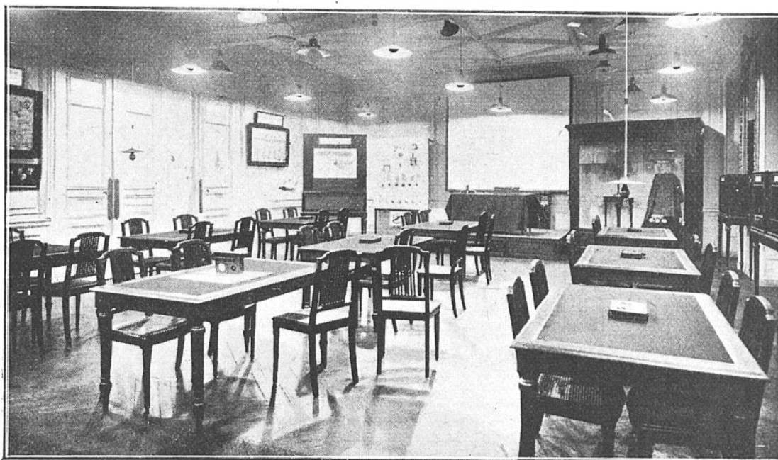
FIG. 11. — GRACE AUN NOMBRE SUFFISANT DE RÉFLECTEURS APPROPRIÉS, MUNIS DE LAMPES DÉPOLIES SUR LEUR HÉMISPHERE INFÉRIEURE, BIEN RÉPARTIS ET SUSPENDUS A LA HAUTEUR CONVENABLE, NOUS OBTENONS ENFIN UN PARFAIT ÉCLAIREMENT DE TOUTE LA SALLE. ON REMARQUERA AUSSI QUE LES OMBRES SONT DOUCES ET LUMINEUSES
