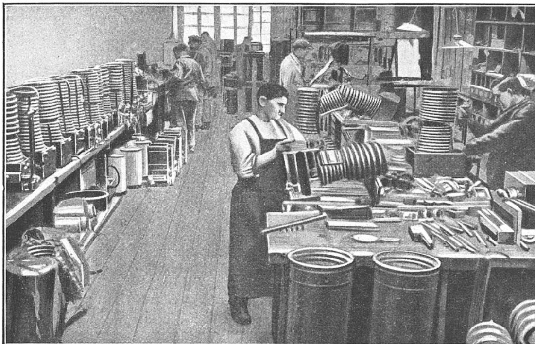
SALLE DE MONTAGE DES SERPENTINS DU CHAUFFE-BAINS « BAYARD »
