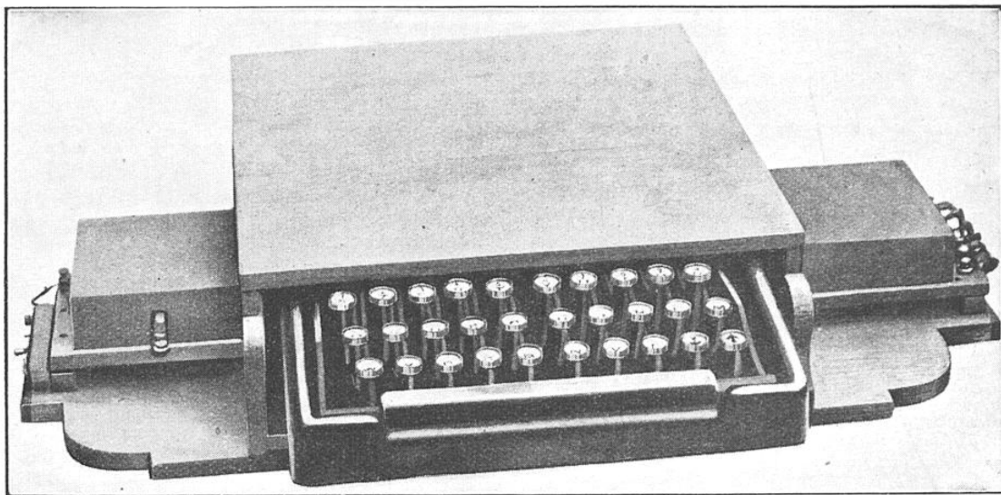
DISPOSITIF TRANSMETTEUR DE LA MACHINE A ÉCRIRE A DISTANCE
