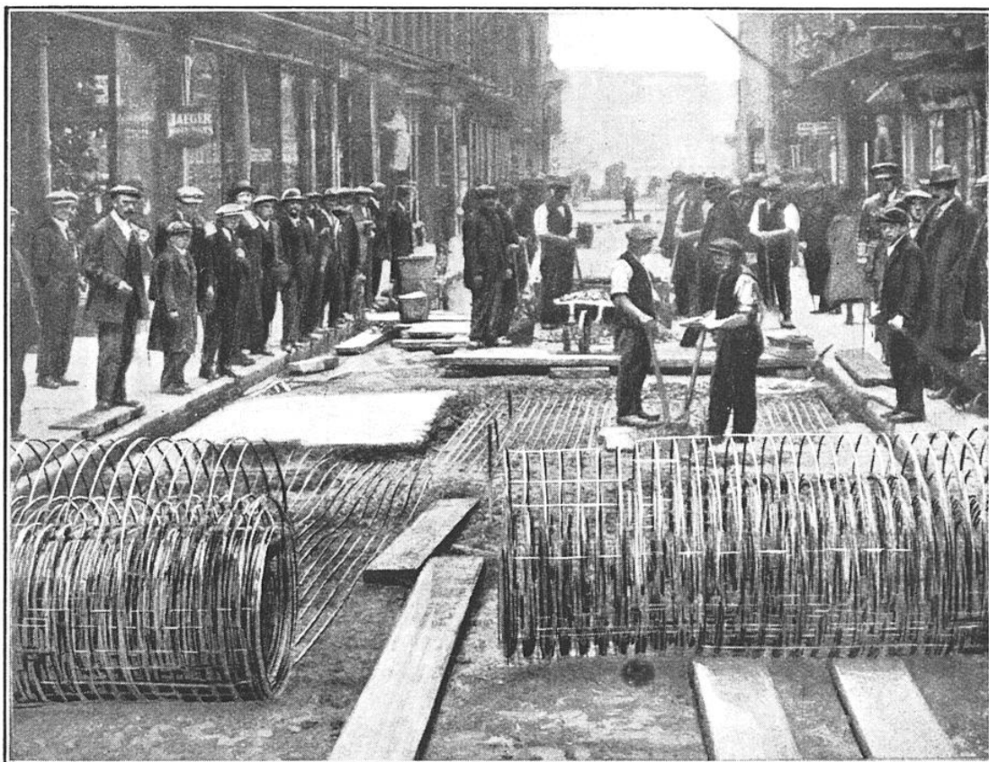
UNE RUE DE LINCOLN (ANGLETERRE) PRÉPARÉE POUR RECEVOIR UN PAVAGE EN BOIS Le lit sur lequel repose le pavage est fait d'une nappe de béton de 15 centimètres d'épaisseur dans laquelle est noyée une sorte de treillis métallique composé de gros fils de fer.
