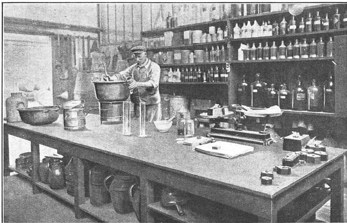
FABRICATION, DANS UNE BASSINE SPÉCIALE, DES ENCRES DE COULEUR : VERTES, ROUGES, BLEUES, ET DES ENCRES D'OR ET D'ARGENT
