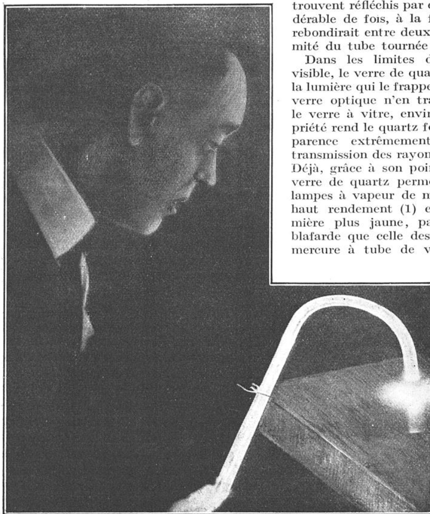
EXPÉRIENCE MONTRANT LE HAUT DEGRÉ DE TRANSPARENCE ET LE REMARQUABLE POUVOIR RÉFLECTEUR DU QUARTZ FONDU PAR LE NOUVEAU PROCÉDÉ DE M. BERRY
