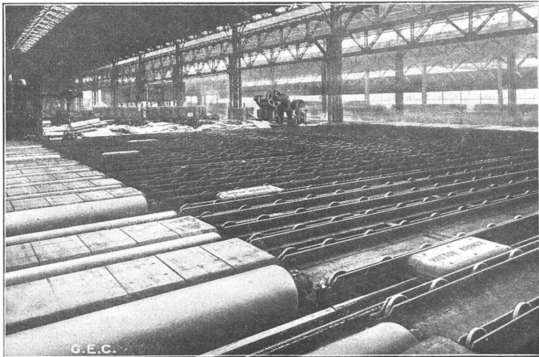
FIG. 1. — VUE GÉNÉRALE D'UN HALL OU LES PLAQUES DE TOLE, AU SORTIR DES LAMINOIRS, SONT AMENÉES A SE REFROIDIR, AVANT D'ÊTRE DÉCOUPÉES PAR LES CISAILLES
