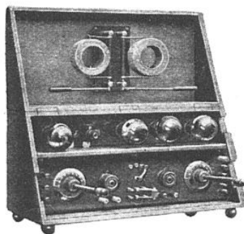
PHOTOGRAPHIE ET MONTAGE DU POSTE DE T. S. F. FONCTIONNANT SUR LE COURANT ALTERNATIF SANS PILES NI ACCUMULA- TEURS
