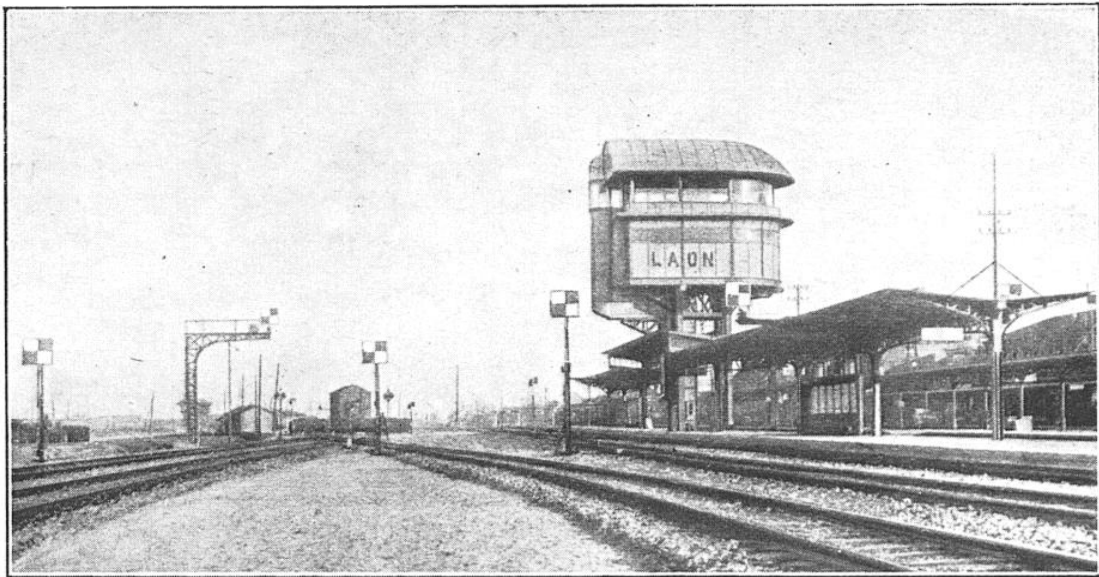
FIG. 5. — DANS LA CABINE DE LAON, SURÉLEVÉE DE 15 MÈTRES AU-DESSUS DES VOIES, L'AIGUILLEUR SE TROUVE PLACÉ DANS UN VÉRITABLE OBSERVATOIRE CENTRAL, D'OU IL DOMINE TOUTE LA GARE ET SES DIVERS AMÉNAGEMENTS
