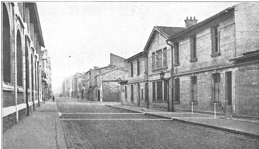
FIG. 8. — LA RUE DE LA FÉDÉRATION, A PARIS, OU ÉTAIT INSTALLÉE UNE STATION D'ESSAIS. Deux fils tendus en travers de la rue et convenablement espacés étaient reliés au chronographe Joly. L'enregistrement des ruptures successives de chacun des fils donnait les éléments de la vitesse du véhicule au moment du passage.
