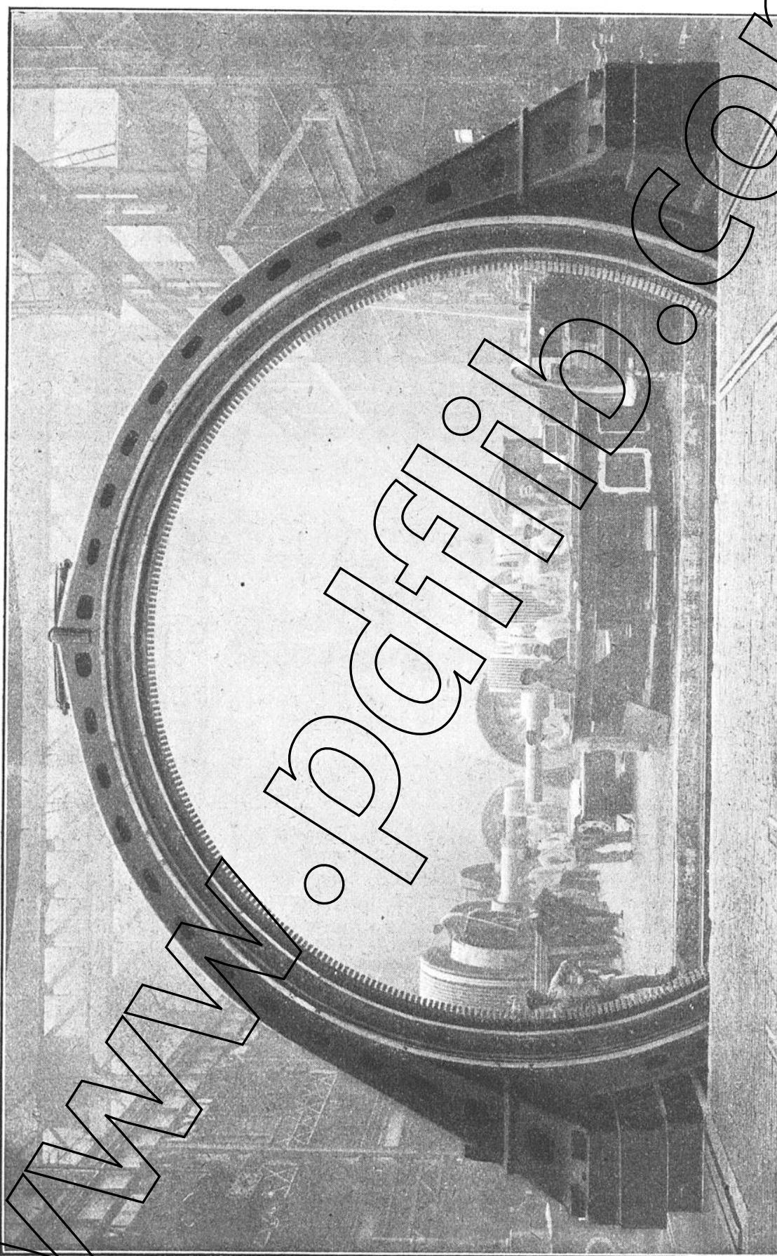
PARTIE FIXE D'UN GRAND ALTERNATEUR VOLANT DE 5.800 KVA., DE 10 MÈTRES 50 DE DIAMÈTRE, PRÊT À ÊTRE ENROULÉ
