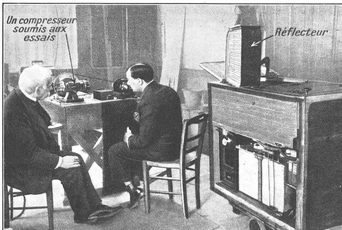
LE RÉFLECTEUR DU STROBORAMA ÉCLAIRE LE COMPRESSEUR PLACÉ À PLUSIEURS MÈTRES. DEUX INGÉNIEURS OBSERVENT AU RALENTI, SIMULTANÉMENT, LES MOUVEMENTS DU COMPRESSEUR À 1.200 TOURS. LA FRÉQUENCE DES ÉCLAIRAGES EST DE 1.200 PÉRIODES
