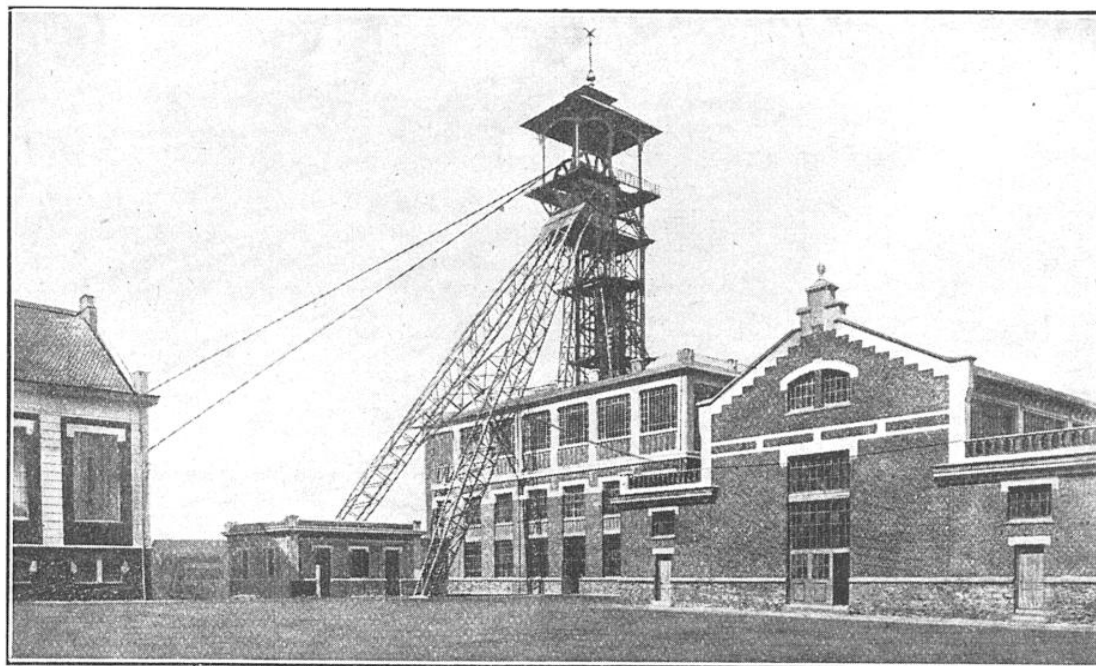
FIG. 15. — VUE DE LA FOSSE II, DE LA SOCIÉTÉ DES MINES DE LENS Cette fosse, complètement électrifiée, extrait 200 tonnes de houille par heure de travail.
