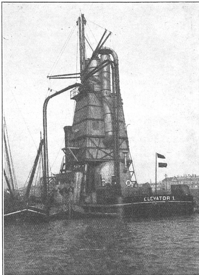
L'ÉLÉVATEUR PNEUMATIQUE ASPIRE RAPIDEMENT LE GRAIN CONTENU DANS LES FLANCS DU CARGO
