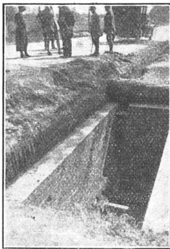
CHAMBRE SOUTERRAINE DESTINÉE A RECEVOIR LES BOITES CONTENANT LES BOBINES DE CHARGE
