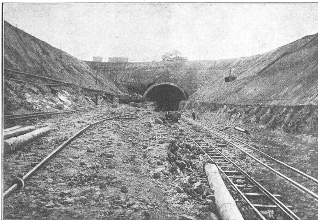
DÉBOUCHÉ DU SOUTERRAIN DU ROVE DANS LA TRANCHEE DE GIGNAC. ÉTAT DES TRAVAUX EN AVRIL 1925
