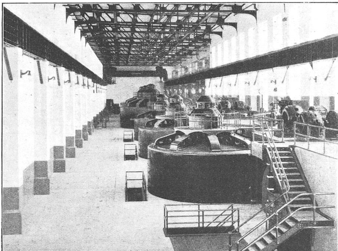
LA SALLE DES MACHINES DE LA CENTRALE DE LA NIAGARA FALLS POWER COMPANY Au premier plan, trois groupes générateurs de 37.500 chevaux. Au fond, des groupes donnant chacun 70.000 chevaux, les plus puissants du monde entier.
