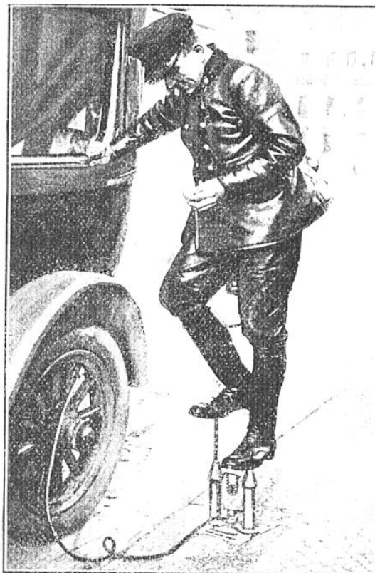
UNE POMPE ORIGINALE POUR GONFLER, SANS FATIGUE, LES PNEUMATIQUES D'AUTOMOBILE
