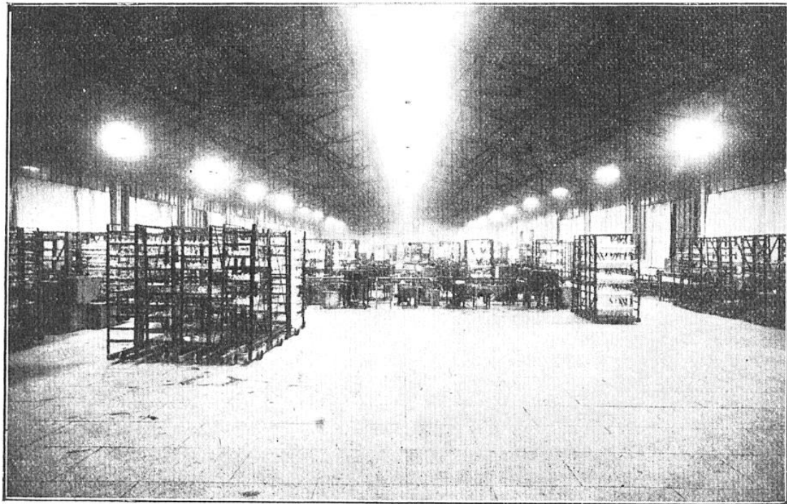
ÉCLAIRAGE GÉNÉRAL D'UN ATELIER AU MOYEN D'APPAREILS A RÉFLECTEURS
