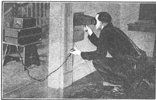
GRACE AUX RAYONS X, L'ÉLECTRICIEN PEUT, SANS DÉTÉRIORER LES MURS, VÉRIFIER LES CANALISATIONS QU'ILS RENFERMENT
