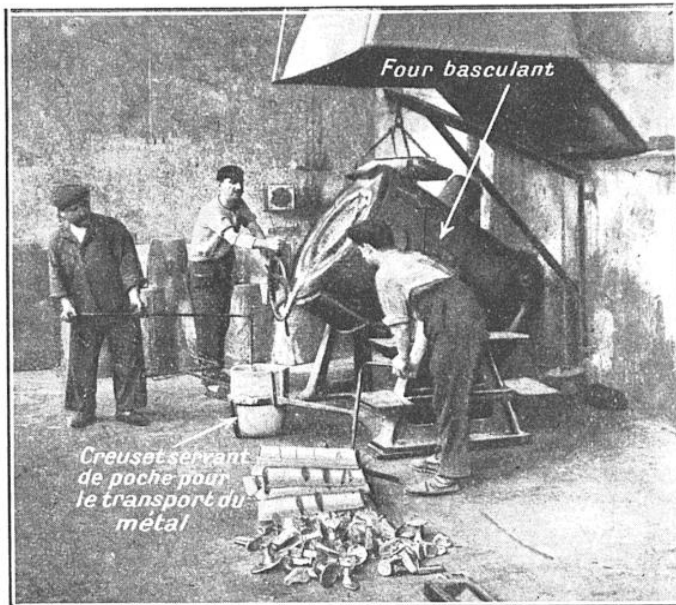
LA COULÉE D'UN ALLIAGE D'ALUMINIUM
