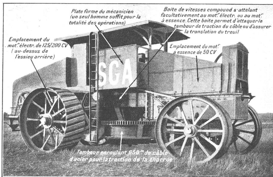
TREUIL S. G. A. POUR LABOURAGE ÉLECTRIQUE
