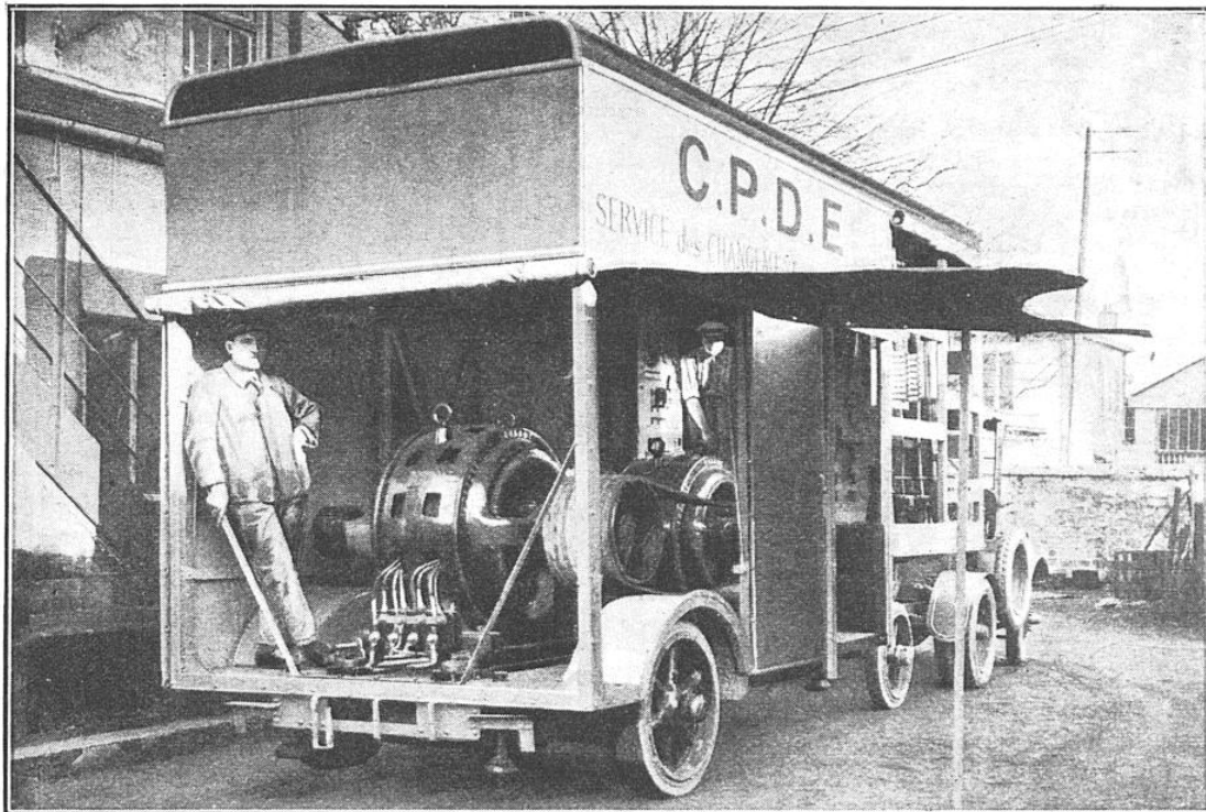
FIG. 4. — VUE ARRIÈRE DE LA STATION MOBILE
