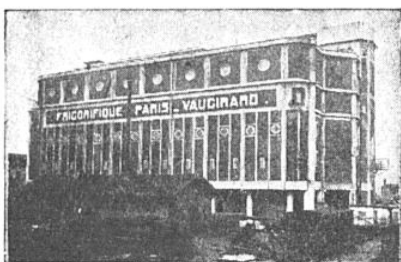
Vue générale des entrepôts frigorifiques de Paris-Vaugirard
