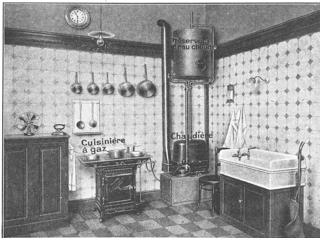
INSTALLATION D'UNE CHAUDIÈRE « CONNÉTABLE » ET D'UNE CUISINIÈRE « EXCELSIOR » DANS UNE CUISINE MODERNE PAR LES ÉTABLISSEMENTS « BRACHET ET RICHARD »
