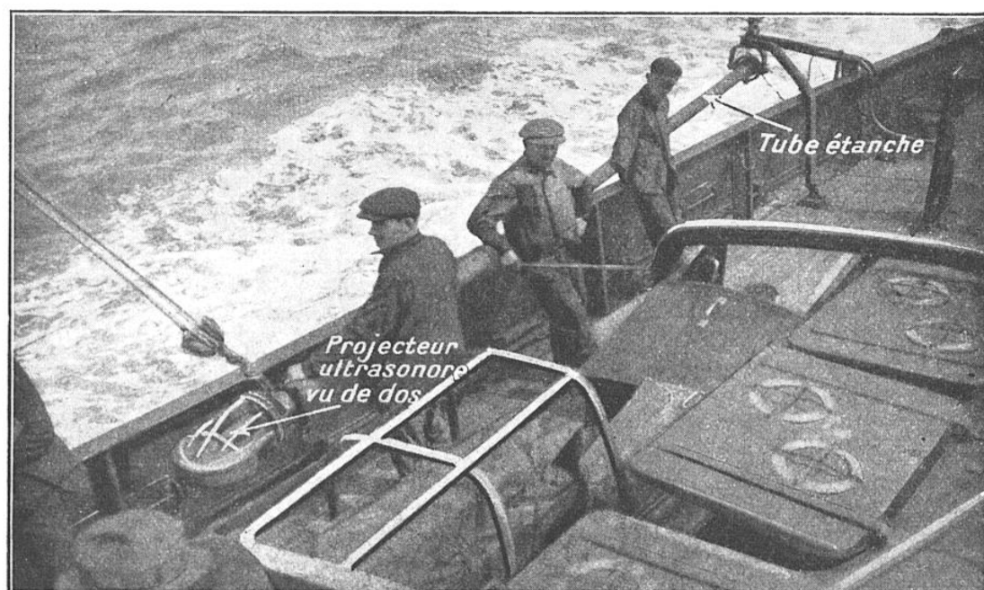
PRÉPARATIF DE MISE A L'EAU DU TUBE PORTE-PROJECTEUR A BORD DU « CHAMPION » QUI A ÉTÉ UTILISÉ POUR EFFECTUER LES EXPÉRIENCES AU PORT DE CALAIS
