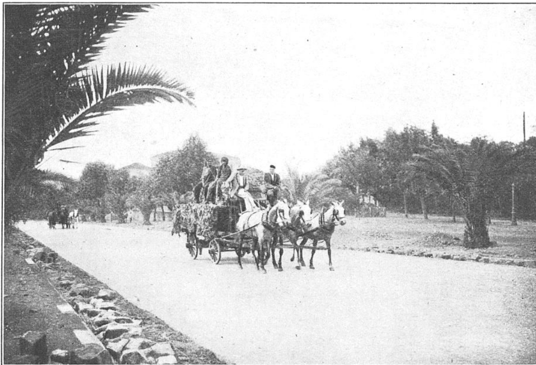
LA ROUTE NATIONALE N° 12 A PHILIPPEVILLE (ALGÉRIE) EST CONSTRUITE EN BÉTON DE CIMENT
