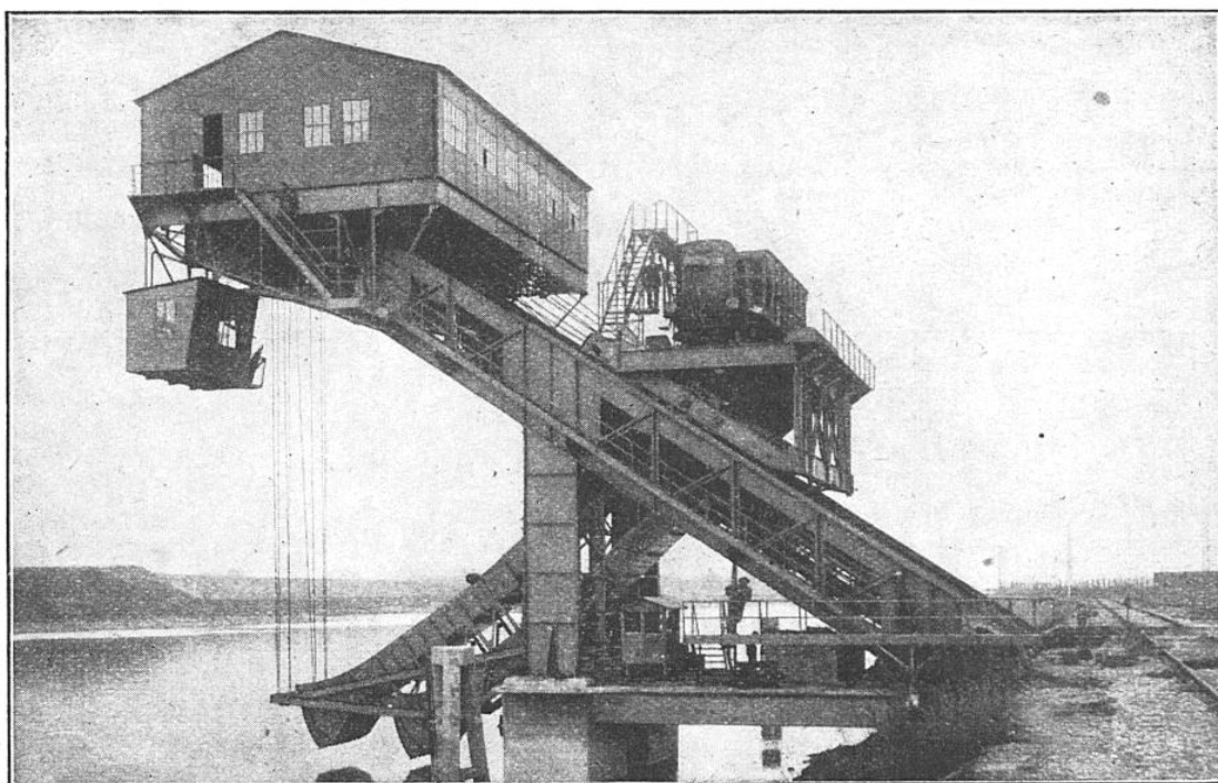
LE MINÉRAI CONTENU DANS LE WAGON TOMBE AUTOMATIQUEMENT DANS DES GOULOTTES QUI LE RÉPARTISSENT DANS LE CHALAND
