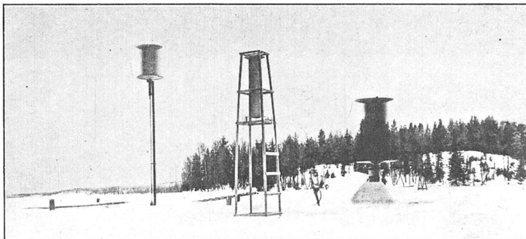
FIG. 4. — DIVERS TYPES DE ROTORS A AUBES, DE SAVONIUS
