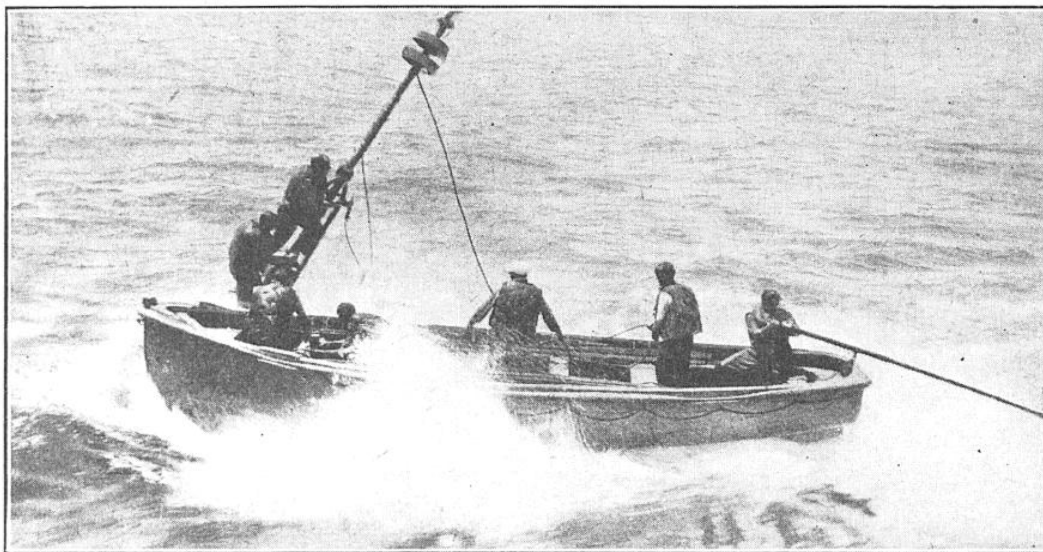
UN CANOT VIENT RELEVER UNE BOUÉE, LORSQUE LA RÉPARATION DU CÂBLE EST TERMINÉE
