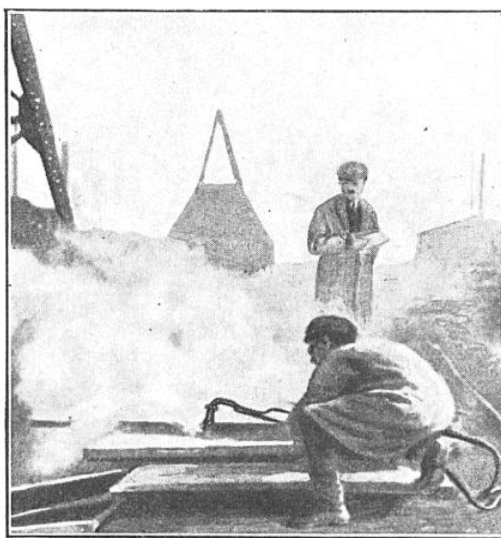
FIG. 1. — LE CHALUMEAU OXYHYDRIQUE DÉCOUPE AISÉMENT DES TOLES ÉPAISSES
