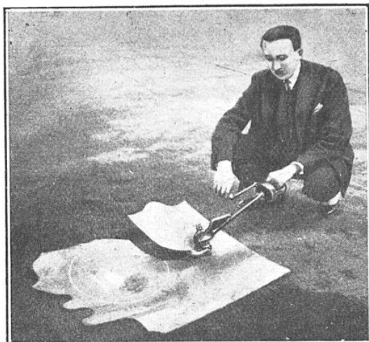
FIG. 11. — LA CISAILLE « NAGEOTTE »
