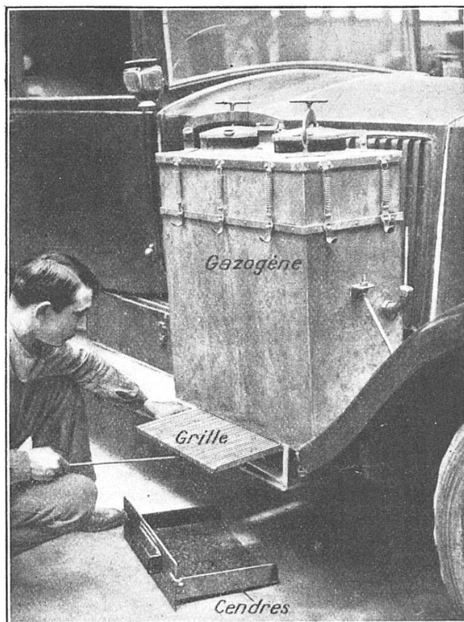
LE DÉCHARGEMENT DES CENDRES DU GAZOGÈNE CHARLES ROUX, INSTALLÉ SUR LE MARCHEPIED DROIT DE L'AUTO
