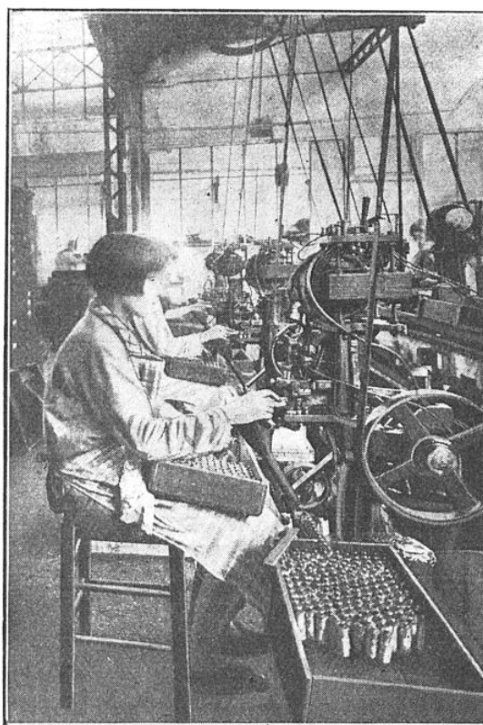
UNE BATTERIE DE FONDEUSES ÉLECTRIQUES
