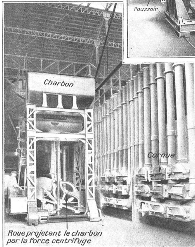
FIG. 1. — LA CHARGEUSE DE CHARBON DE « BROUWER » Cet appareil lance le charbon horizontalement, par effet de force centrifuge, dans la cornue ouverte.
