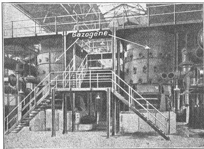
FIG. 9. — VUE PARTIELLE DE LA STATION CENTRALE DES GAZOGÈNES « KERPELY-MARISCHKA »
