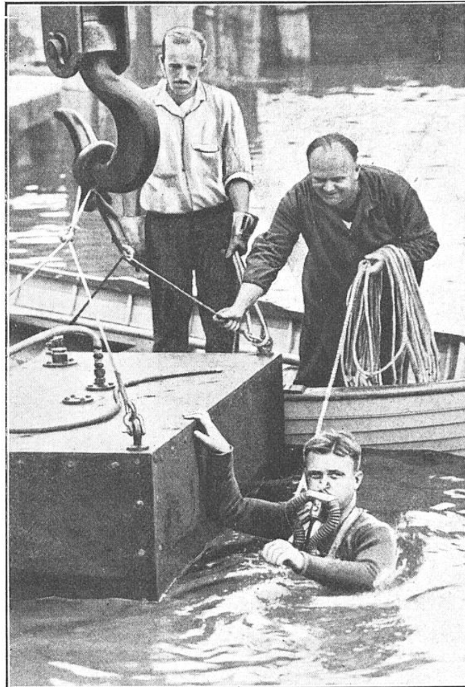
UN DISPOSITIF QUI PERMET AUX MEMBRES DE L'ÉQUIPAGE D'UN SOUS-MARIN COULÉ DE REMONTER À LA SURFACE DE L'EAU
